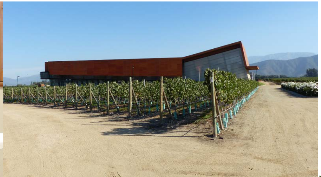
Santa Emas neuer Weinkeller in Balmaceda
